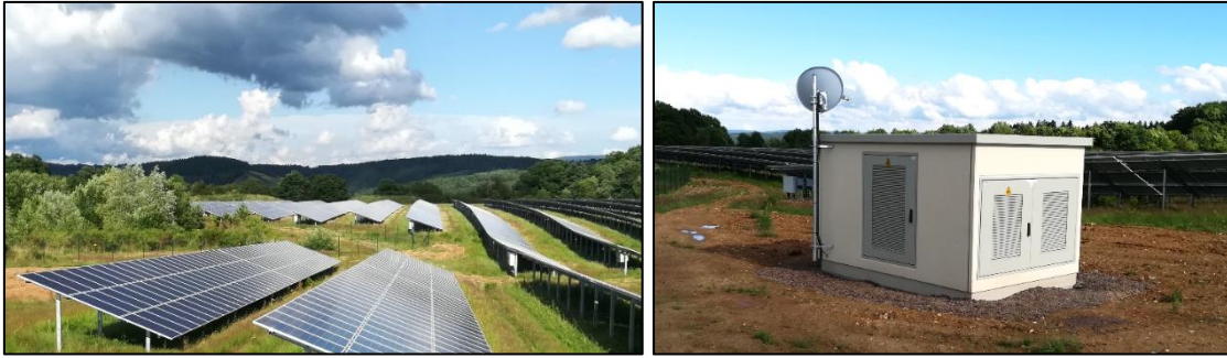
Abb. 2: Beispiel einer Freiflächenanlage (Höhe über Geländeunterkante ca. 80 cm) (links) und einer Trafostation (rechts) (Foto: BGHplan Juni 2017).
