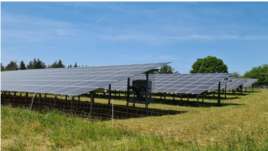
Abb. 2: Beispiel einer Ost-West ausgerichteten Freiflächenanlage (oben) und einer nach Süden ausgerichteten Freiflächenanlage (unten), (Fotos: BGHplan).
