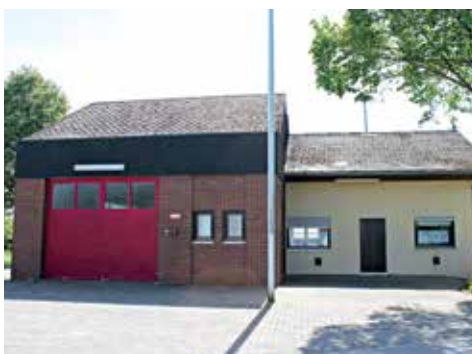
Feuerwehrgeräte- und Gemeindehaus Hosten
