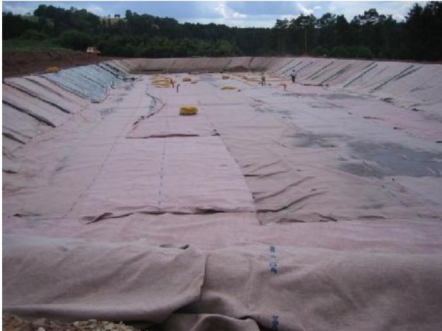
Nach Herstellung des Erdplanums wurde zum Anlegen der Erdbecken der Klärschlammvererdungsanlage eine Schutzlage Sand in einer Stärke von ca. 10 cm aufgebracht. Hierauf wurde die eigentliche Abdichtung in Form von 2,5 mm starken und ca. 4 m breiten PE-Bahnen, die wasserdicht miteinander verschweißt wurden verlegt. Darauf wurde ein Filterkörper in einer Stärke von ca. 30 – 40 cm aufgebracht. Im Filterkörper sind wiederum Drainageleitungen verlegt, die das Restwasser aus
