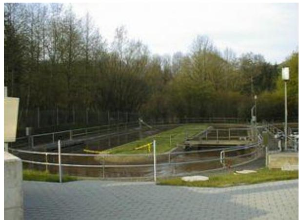
Im Jahre 1965 begann man bereits mit der Planung zum Bau einer Kläranlage. Der Bau der Kläranlage und der Ortsentwässerung Spangdahlem erfolgte in den Jahren 1974 – 1978. Die Entwässerungsleitungen mit einer Länge von 8.456 m wurden ausschließlich im Mischsystem verlegt. Zur Entlastung wurden 3 Regenüberlaufbauwerke errichtet. Die Investitionskosten betragen 340.000,00 € und wurden vom Land mit 235.000,00 € bezuschusst.
